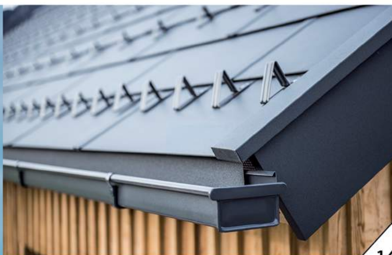
Sistem de drenaj pluvial rectangular
