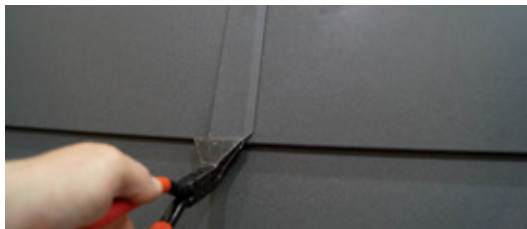
13 Se ridică ușor falțurile laterale.
