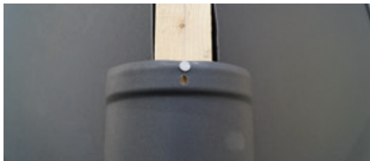
11 În partea superioară, coama se fixează cu un cui zincat.
