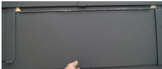
20 ... se introduce între falțurile laterale și se împinge în sus.
