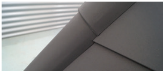
12 Jos, coama se fixează cu șurubul cu garnitur inclus.
