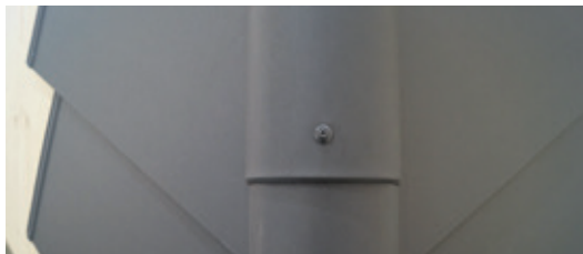
12 Jos, coama se fixează cu șurubul cu garnitur inclus.
