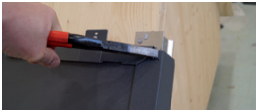
7+8 Se îndoie marginea pentru poziționarea următorului element
