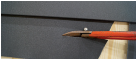
17 + 18 Se taie bucata rămasă de modul la o distanță de 50mm.
