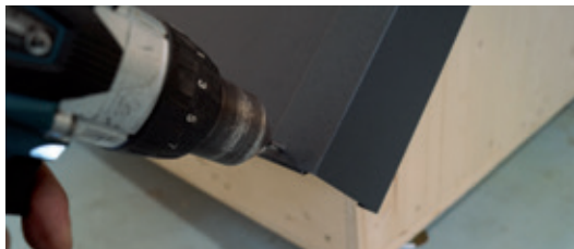
2 Primul element lateral se fixează cu nit
